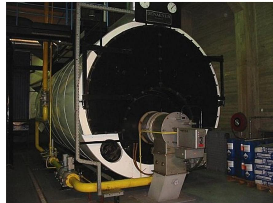
*Une des 2 grandes chaudières de la chaufferie principale (11,6 MW), qui comprend également une 3ème chaudière plus petite (5,8 MW).*
